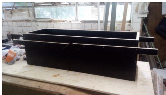
Figura 3 - forma para a concretagem dos pilares da pesquisa.
