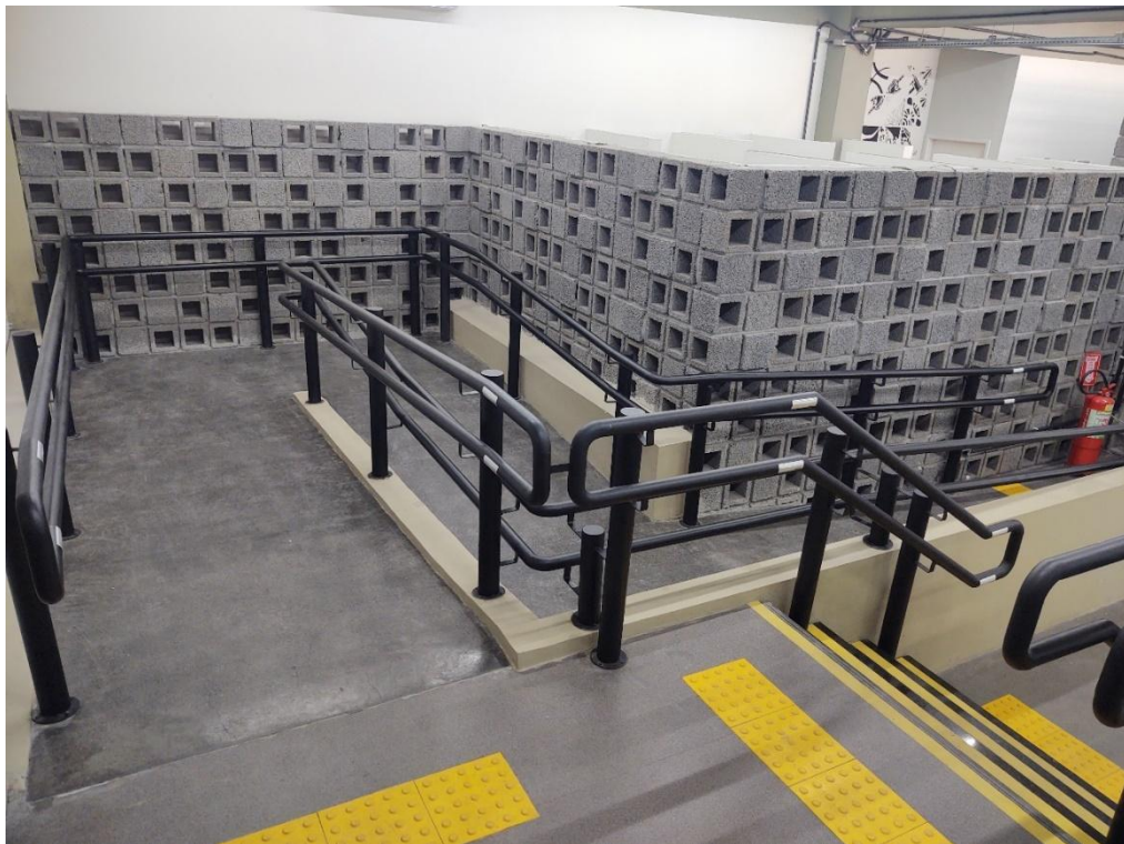
Biblioteca: Rampa com corrimão
