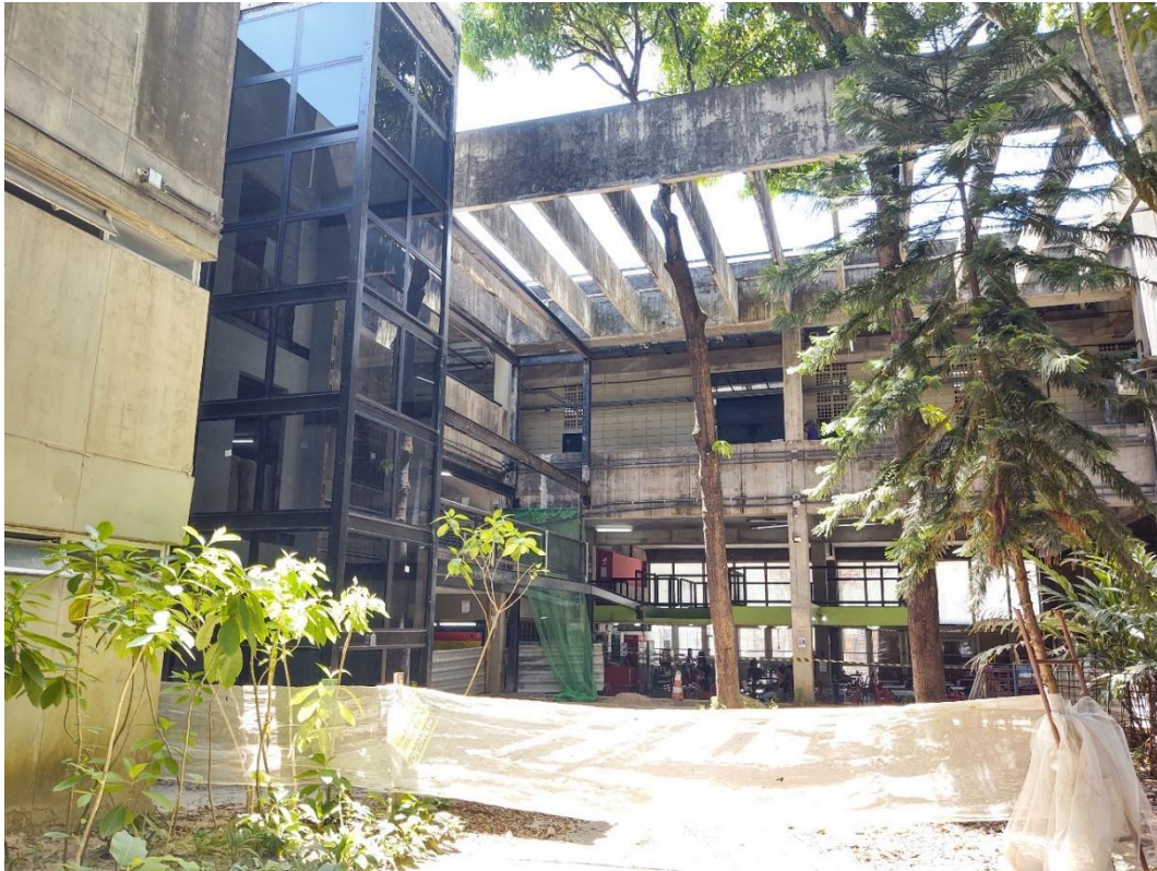
Estrutura metálica do elevador e passarela
