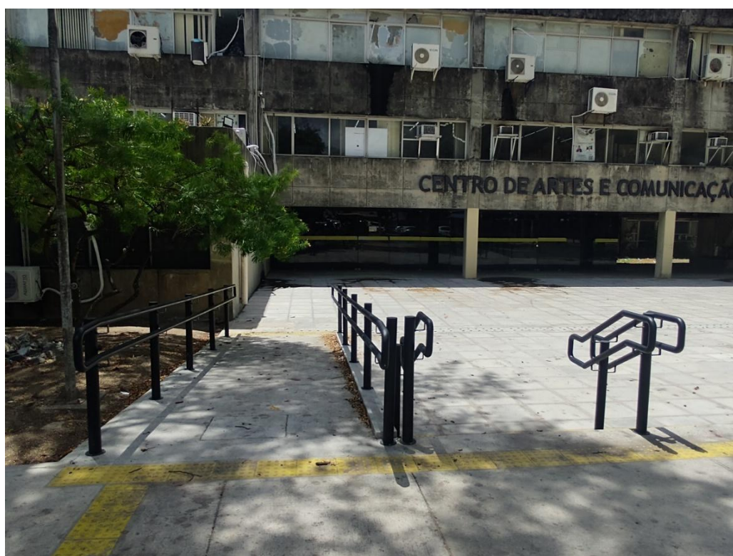
Construção de rampa e escada, instalação de corrimão e piso tátil
