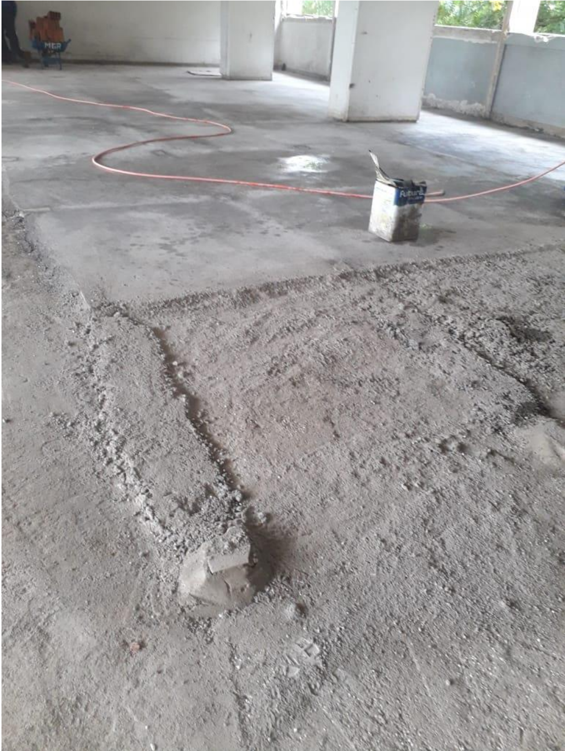
Figura 2 – Realização do contrapiso.
