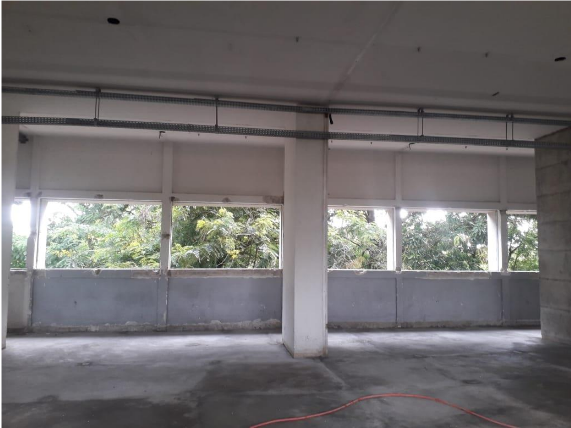
Figura 6 – Retirada esquadrias.
