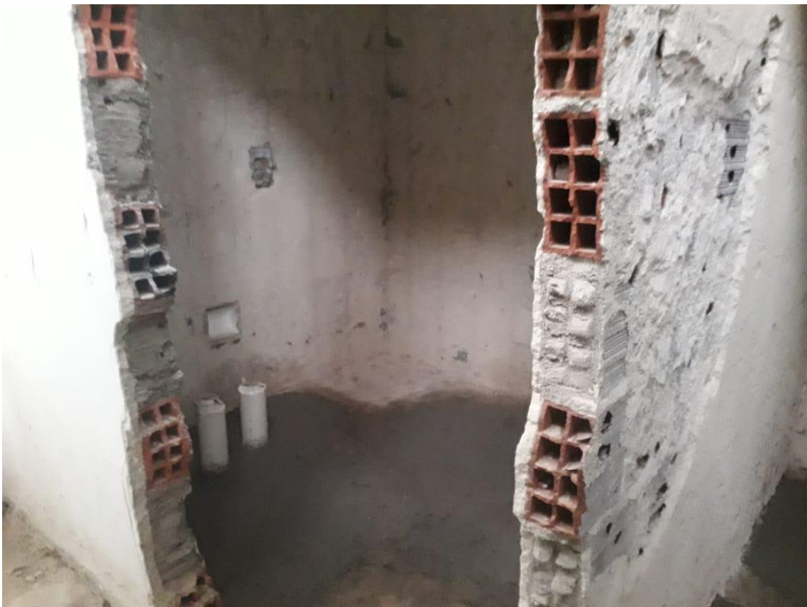
Figura 4 – Realização do contrapiso.
