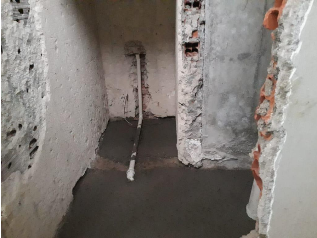
Figura 3 – Realização do contrapiso.
