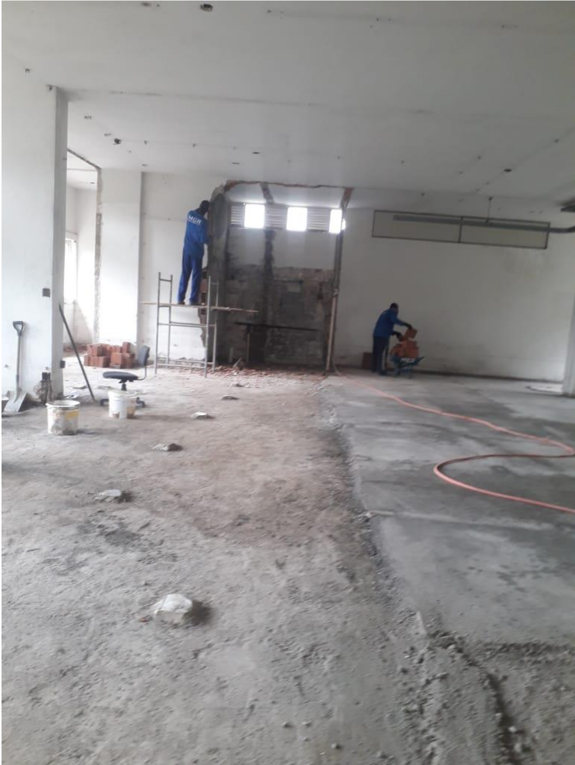
Figura 5 – Demolição alvenaria.
